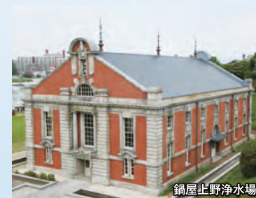
鍋屋上野浄水場
